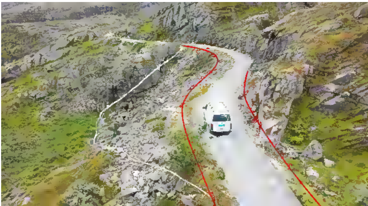
Figur 3. Område langs veien der det etableres fylling ut mot dalsiden, i tillegg til at man utvider inn mot fjellsiden. Omtrentlig veiutvidelse og størrelse på fylling er skissert inn på bildet.
